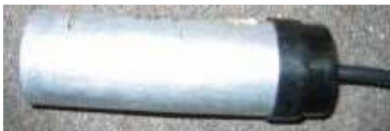
Zaščitna kapa na kondenzatorju
